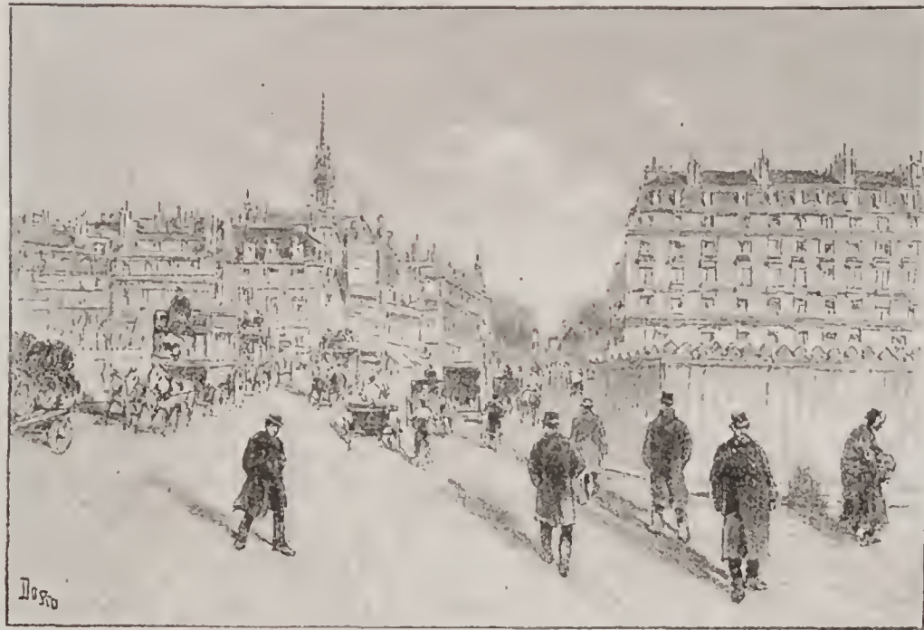
LES TRAVAUX DE PARIS.
